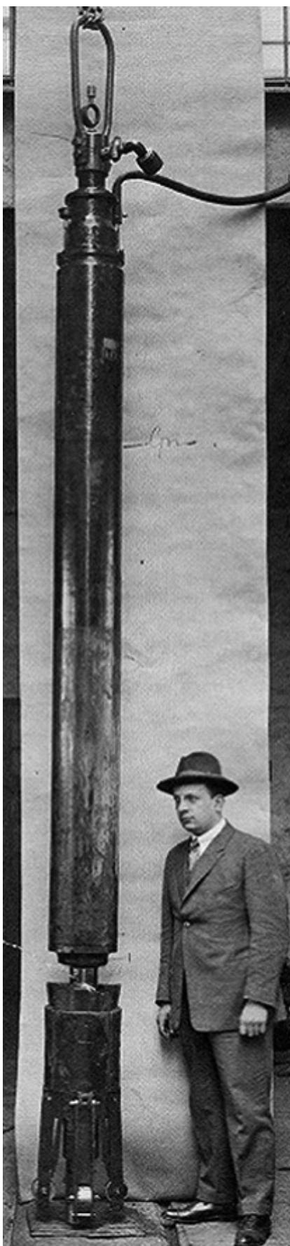
Создатель погружного скважинного насоса и его детище
